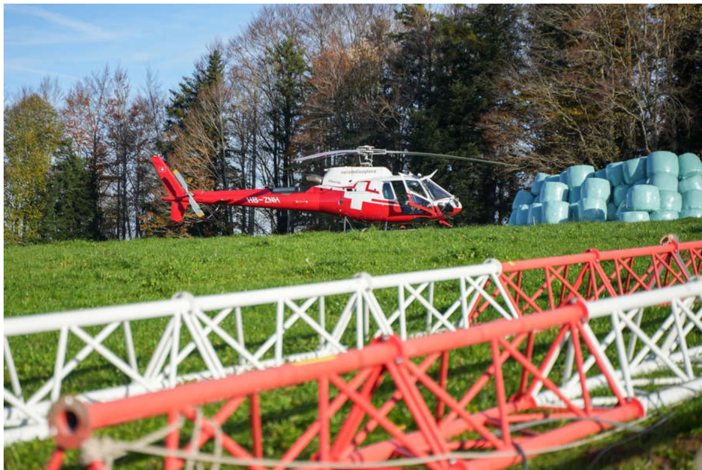
L'hélicoptère a démonté morceau par morceau les mâts de mesures. © BIST/Jonas Lüthi
