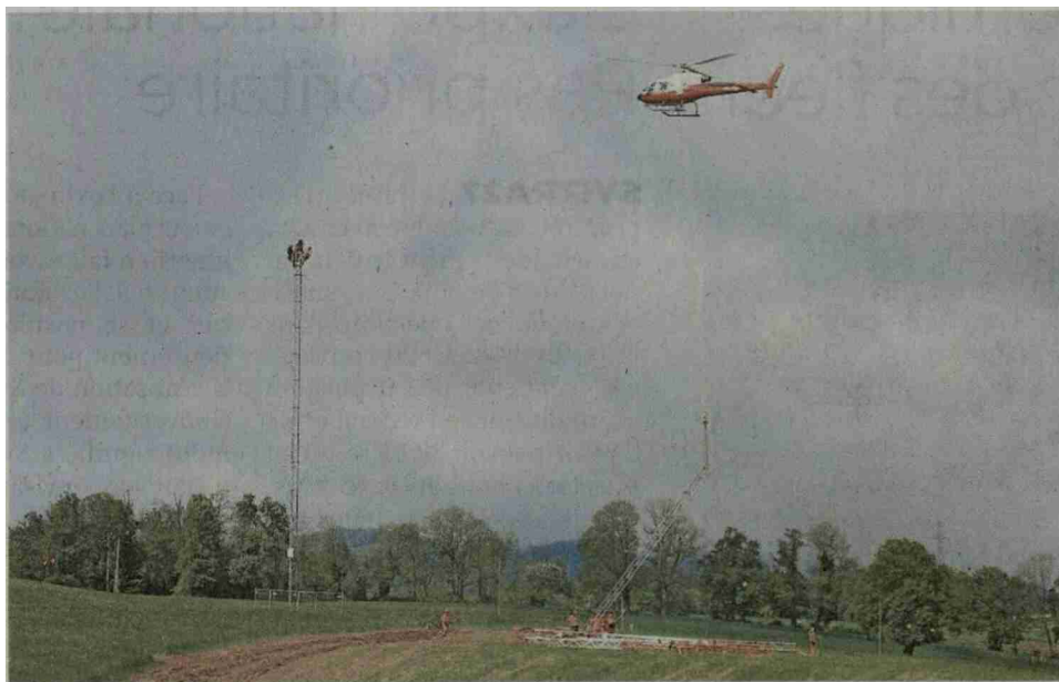
L'hélicoptère apporte le deuxième morceau de l'un des trois mâts de mesure, posés pour le Parc éolien de la Haute-Borne.
