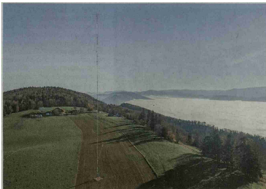
Sous le soleil de la Haute-Borne, un mât installé en mai procède à différentes mesures en vue de la conception du projet pilote de parc éolien. PHOTO JONAS LÜTHI
